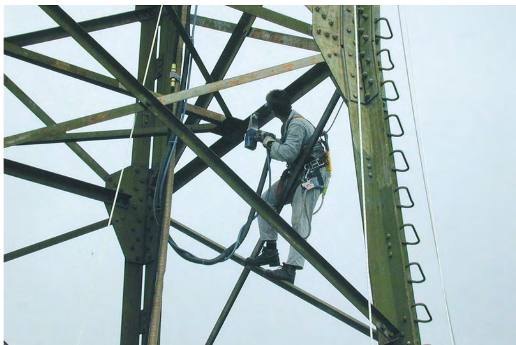
Rengöring och förbehandling med laser istället för exempelvis blästersand eller vatten innebär flera fördelar. Bland annat sliter inte tekniken på underlaget.
