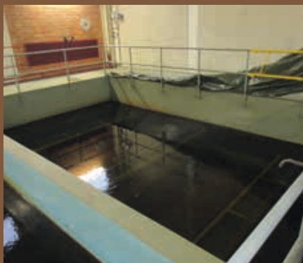
Avjärningsbassäng renoverad med polyurea.
