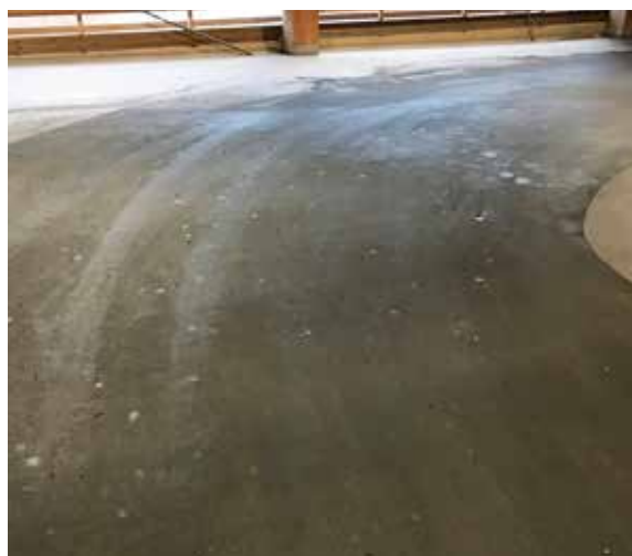
Reparationsåtgärder på härdplastbeläggning i trägarage.
