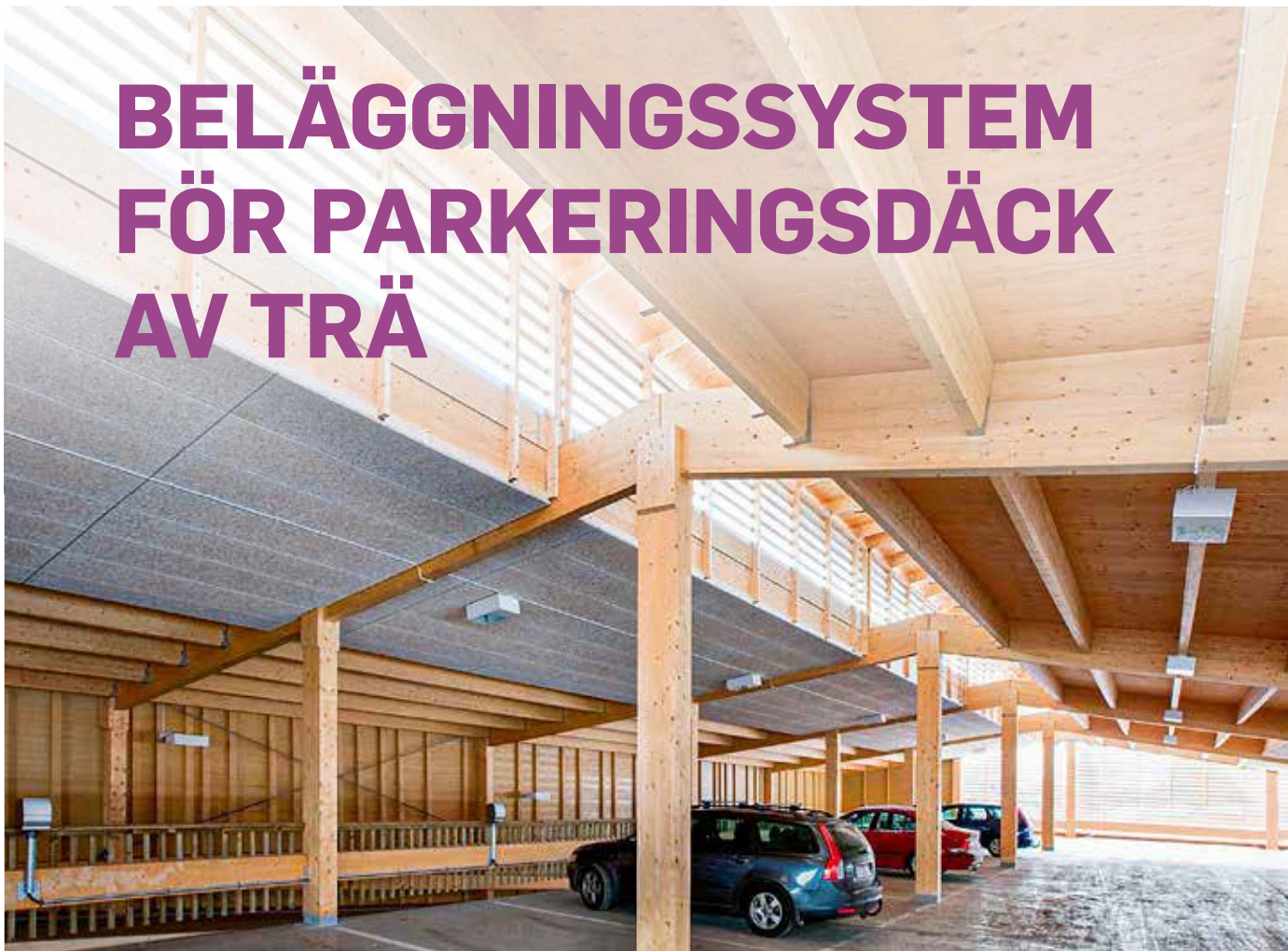
Parkeringshuset i Skellefteå stod klart 2009 och är Nordens första parkeringshus i trä. Två plan är i betong under jord och fyra plan i trä ovan jord. Stomme, bjälklag, ytterväggar och hisschakt är av limträbalkar och korslaminerat trä.
