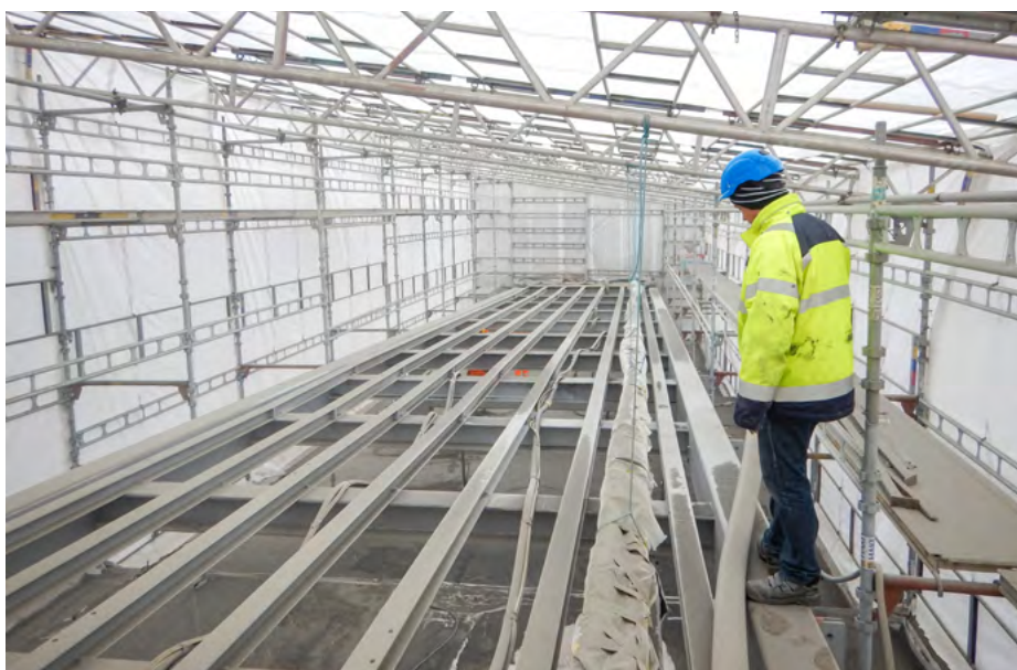
Ommålning av gångbro. När det görs fel i nyproduktion och ska åtgärdas på plats så fördyras objekten katastrofalt, då man i tätortsmiljö måste täcka in objekten.
