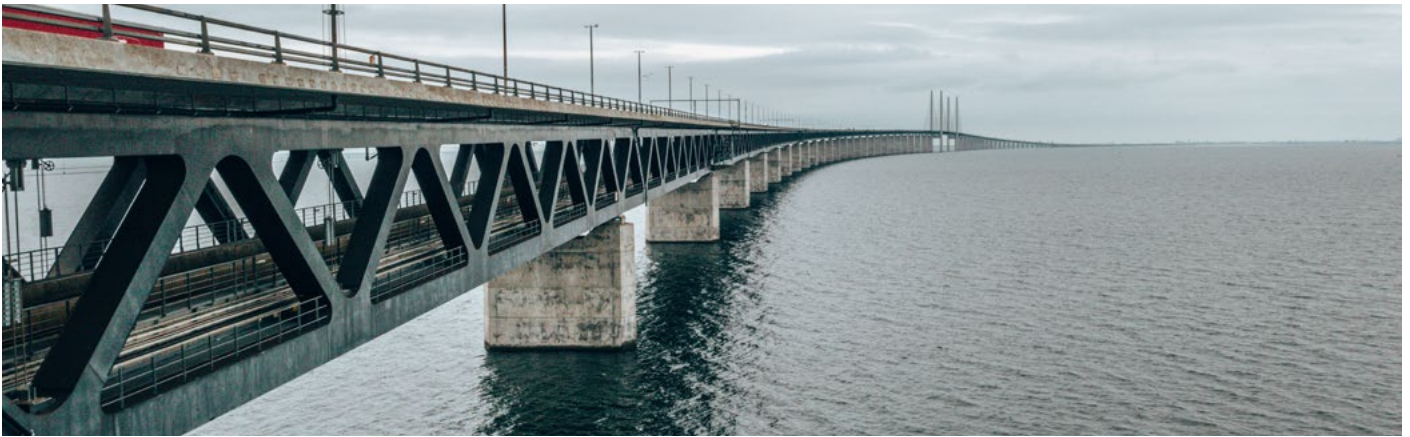
De delar av en konstruktion som befinner sig i regnskugga, kan ha en mycket högre korrosivitetsklass än övriga delar.
