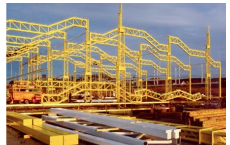
Korrosivitetsklass under byggtiden måste beaktas.
