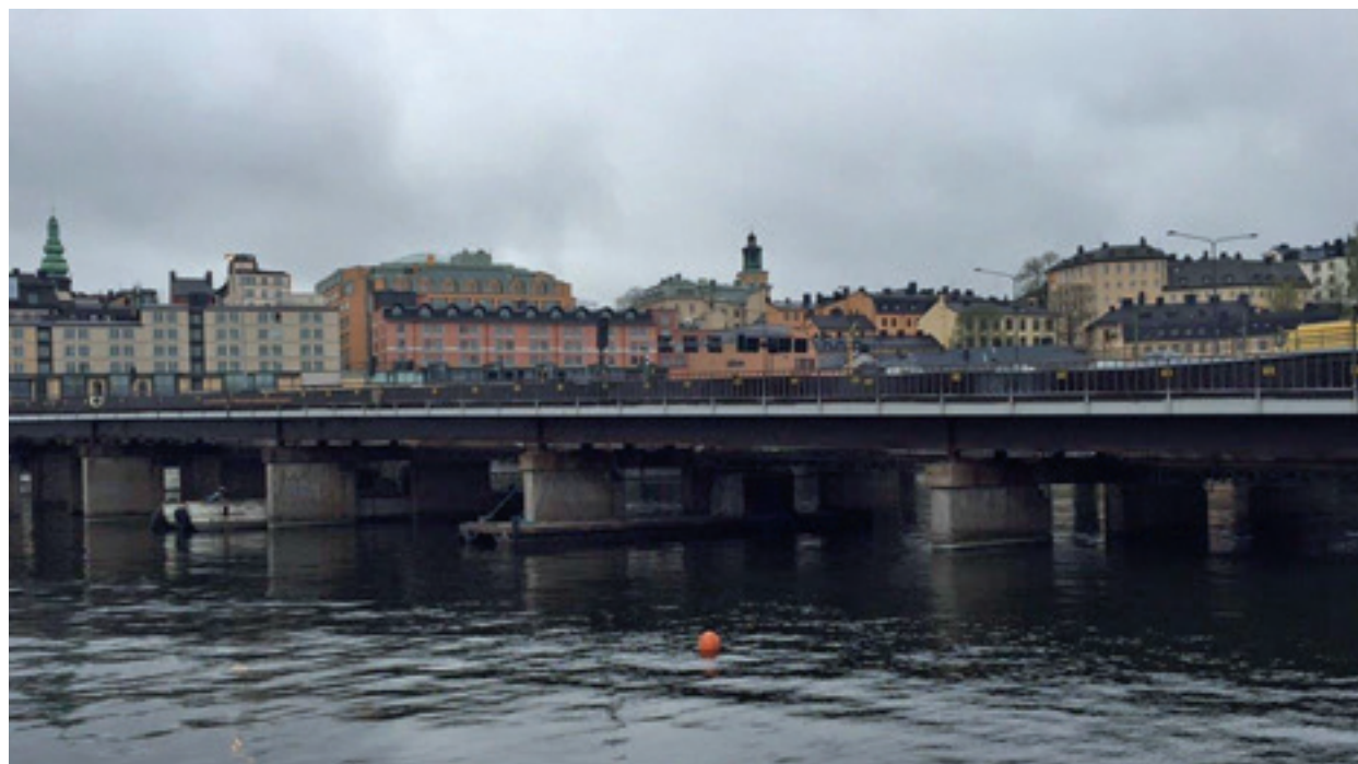
Med sitt läge mitt inne i Stockholm var renoveringen av Söderströmsbron en miljömässig utmaning.
