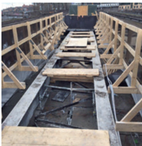
Här har färgen tagits bort och yterna är redo för blåstring av rätt profil för den efterföljande målningen.
